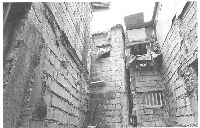
▲火災復興現場の様子
